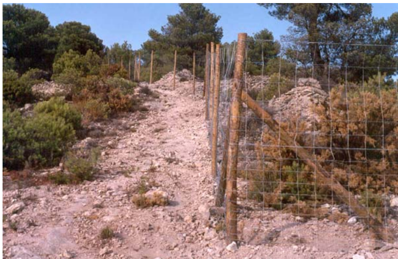
Foto nº4: Tanca cinegètica perimetral sobre postes de fusta tractada
